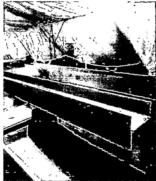
Imagen 1 y 2: Arenado y pintado de vigas para el sistema de defensa del cabezo y plataforma baja.
