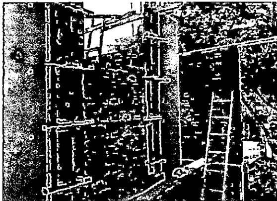
Imagen 10 y 11: Asentado de ladrillos en tanque elevado.
