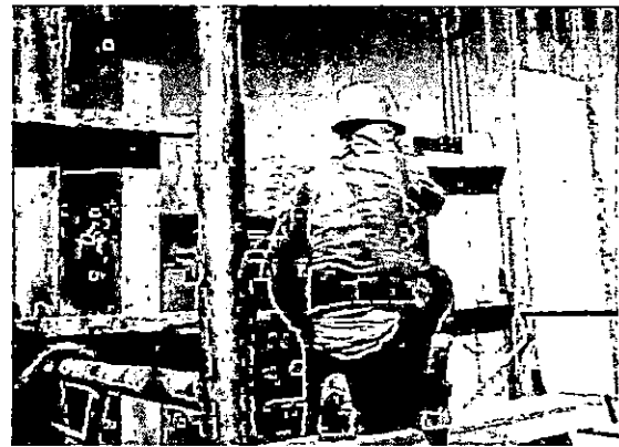
Imagen 10 y 11: Asentado de ladrillos en tanque elevado.
